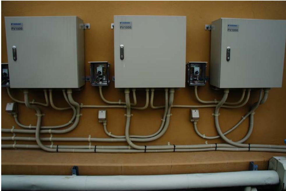
図 20 パワーコンディショナーと専用ブレーカ、コンセント挿入口
