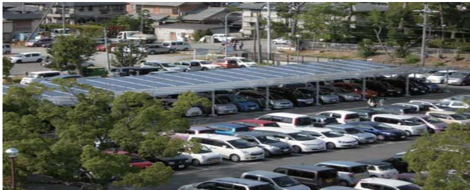
図 10 カーポート型太陽光発電設備
