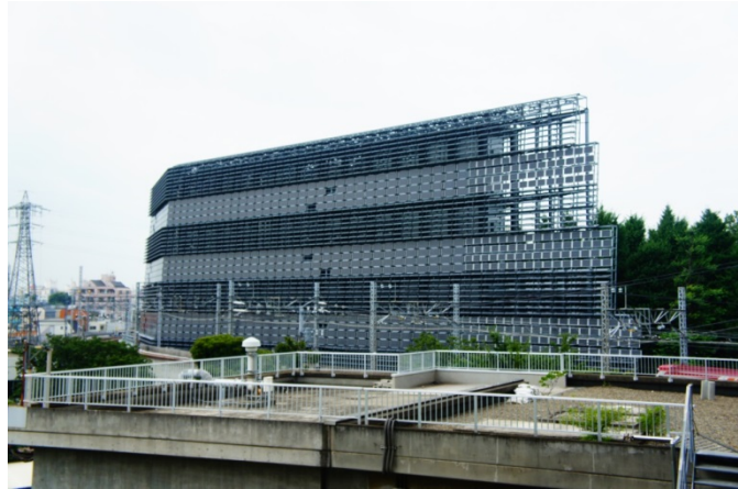
図 7 グリーンヒルズ1号館
