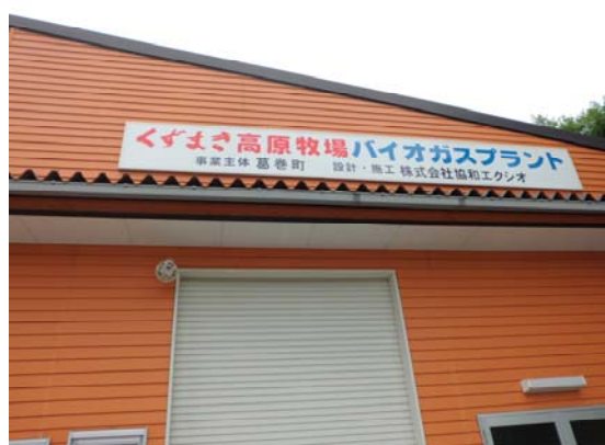
図 6-11 くずまき高原 バイオガスプラント
