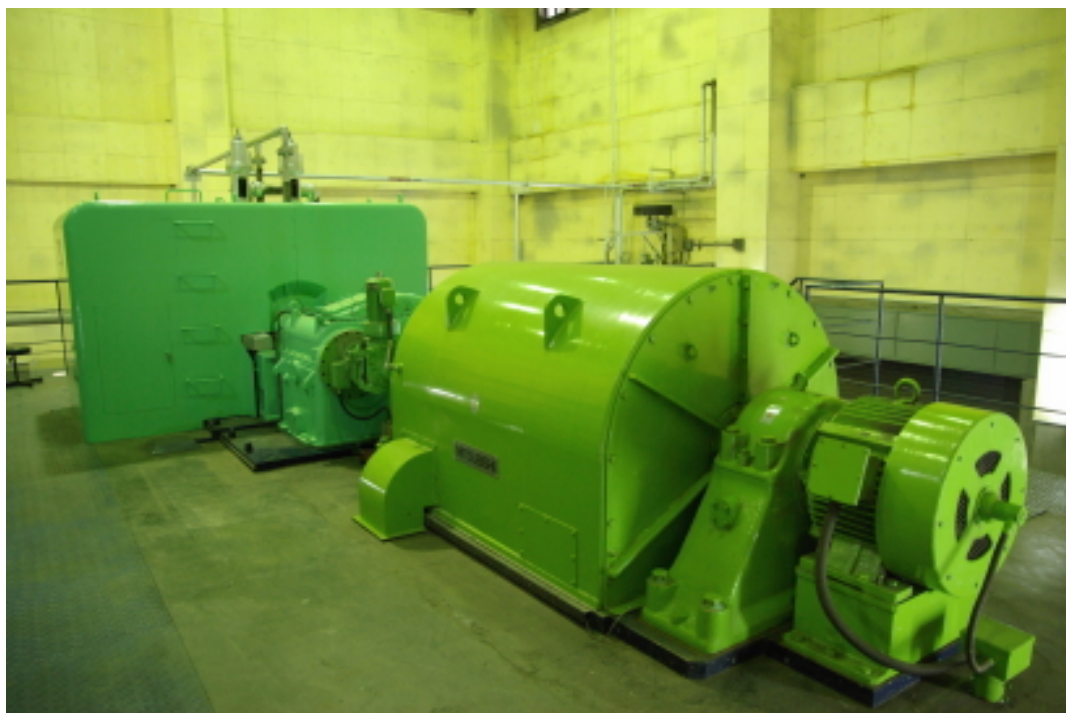
図 6-21 橘センター 蒸気タービン発電機 (2,200kW)
