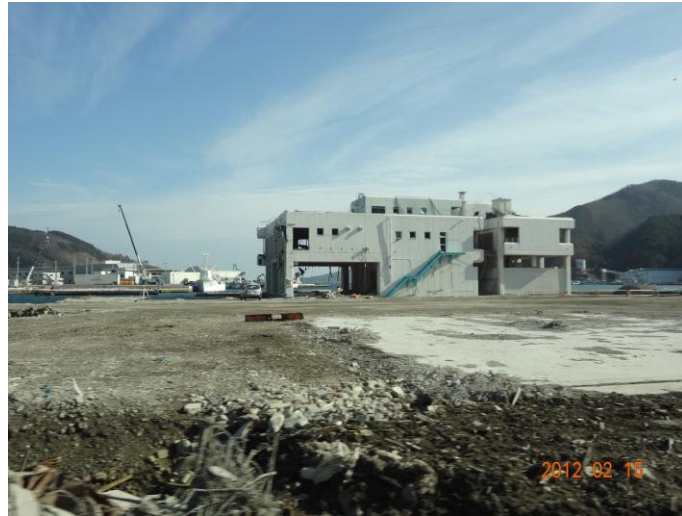
※ 津波が通過し残った鉄筋の建物
