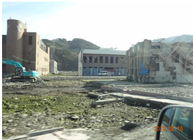
※ 転倒した建物2
