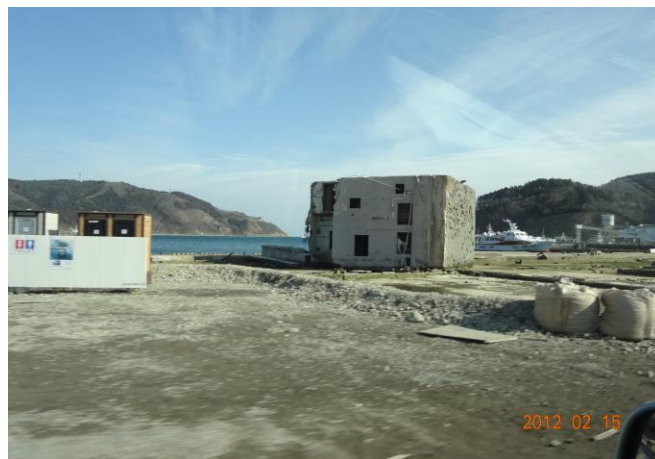
※ 津波により転倒した鉄筋の建物
