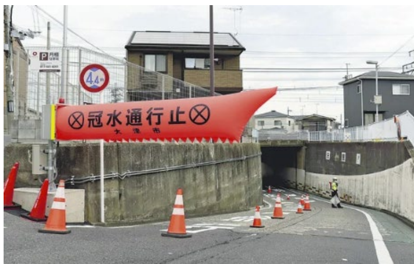
図表 2-25 アンダーパス内の冠水に応じて自動で作動する遮断機（毎日新聞，2023）
