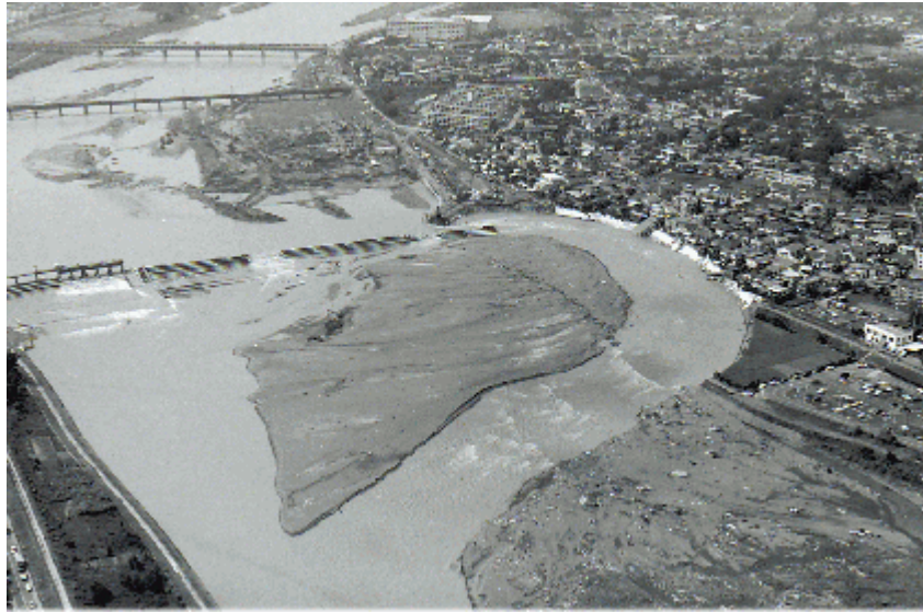
図表 2-13 多摩川堤防決壊（東京都狛江市，2017）
