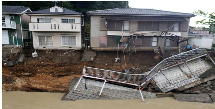
図表 2-11 廿里町南浅川護岸崩壊状況（八王子市生活安全部防災課，2020）
