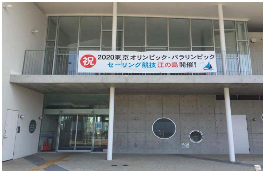
写真 18：ヨットハーバー付近の施設
