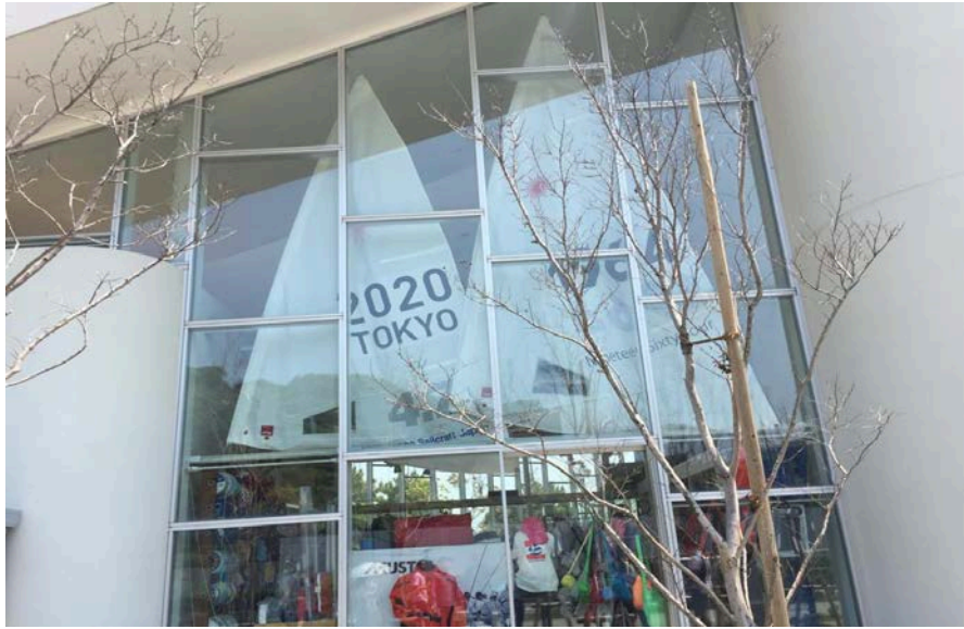
写真 19 : ヨットハーバー付近の施設
