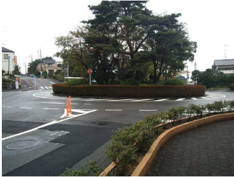
図 44 東京都多摩市に設置されたラウンドアバウト
