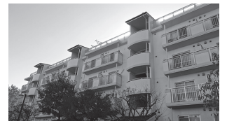
多摩ニュータウンの一角にある地域学生センター 建物は UR 都市機構が所有する鉄筋コンクリート造
