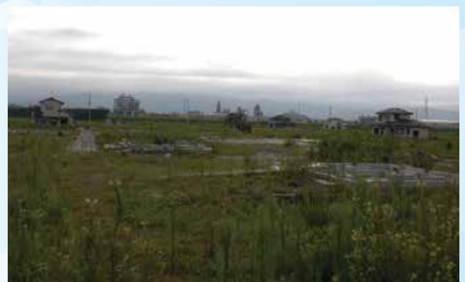
津波で土台しか残っていない相馬市原釜地区(2012年8月)
