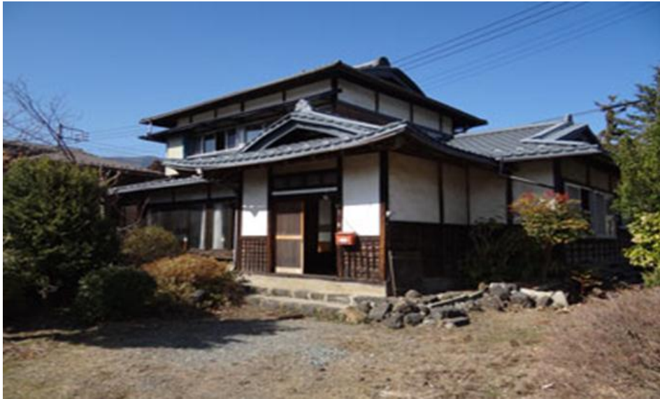
空き家 富士河口湖町小立 外観
